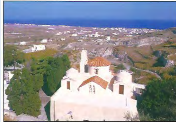
Ο ναός στη δεκαετία του 1990 μετά την αποκατάσταση και ανακατασκευή της στέγης. Γενική άποψη.
